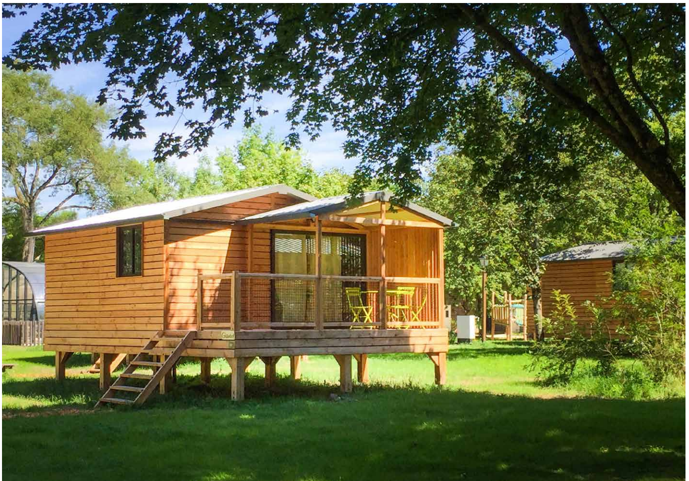
Bracieux. Une habitation légère de loisirs sur pilotis dont le plancher est au-dessus de la cote de crue.
