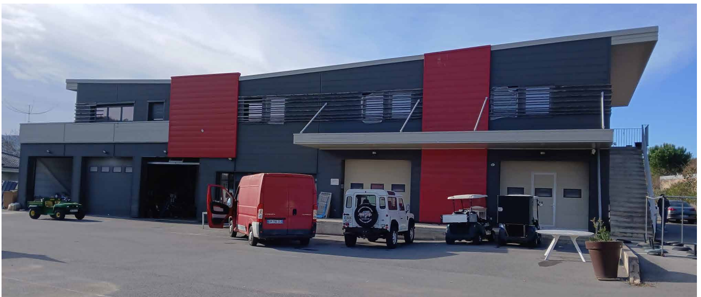
Ardèche. Locaux techniques intégrant les logements des salariés du camping au premier étage.
