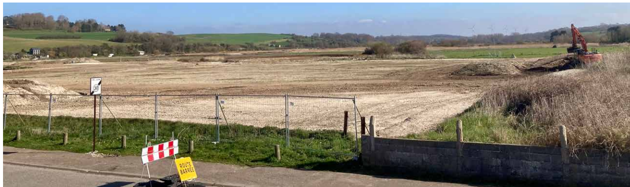
Quiberville-sur-mer. Renaturation complète de l’ancienne assiette foncière du camping après sa relocalisation.
