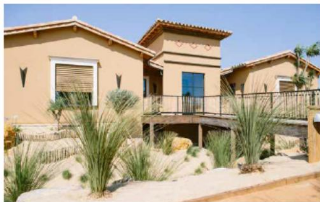
Sérignan plage - Une réception de camping conçue pour laisser circuler l'eau sous le bâtiment
